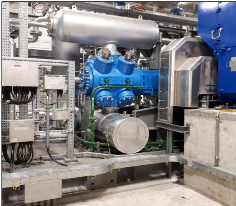
**Figura 2 – Nuovo elettrocompressore C.le Garaguso / Area pozzo AC3**
